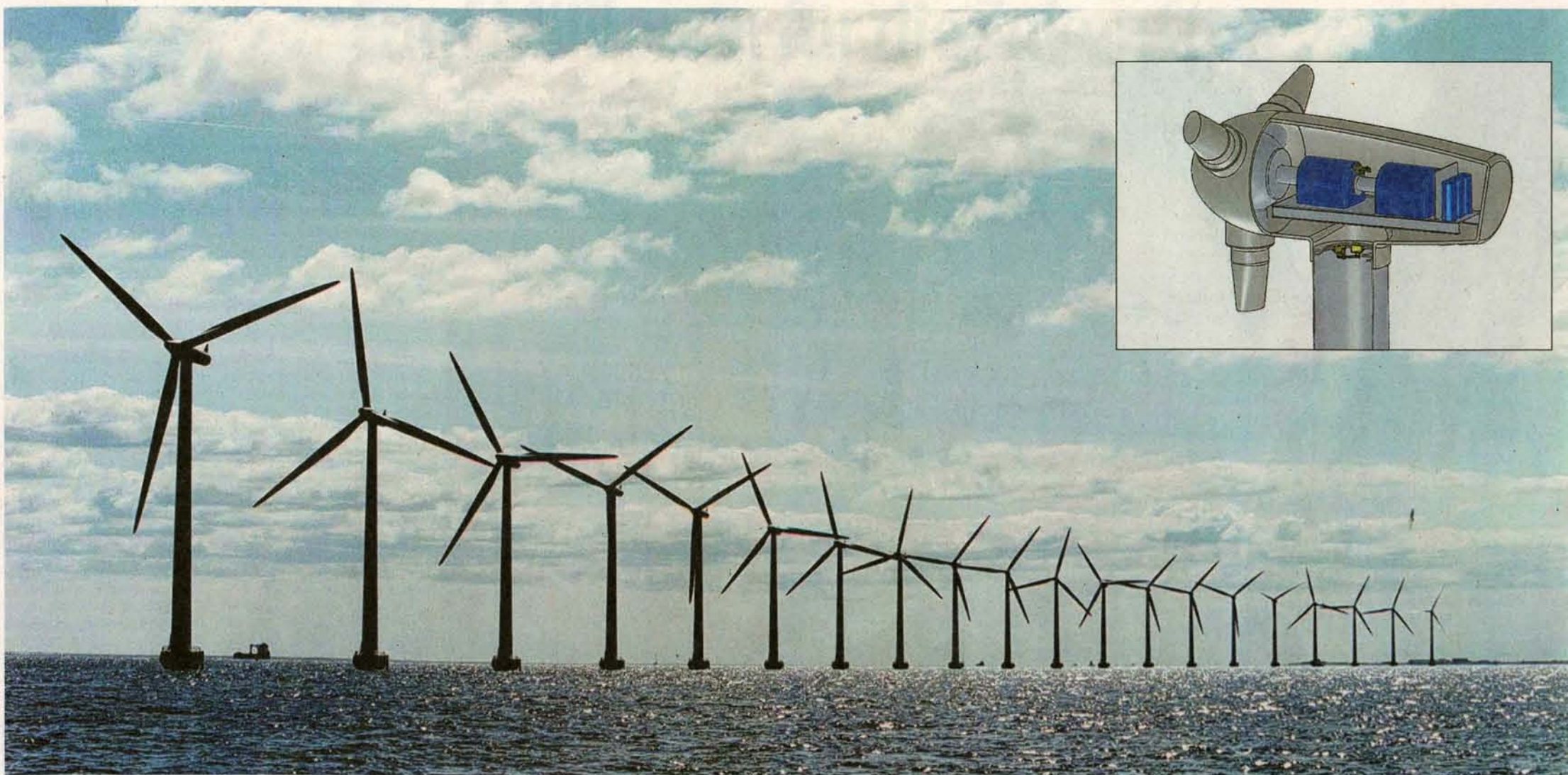
Sorgen für Sicherheit: Zwischen Generator und Getriebe sitzt die Rotorbremse. Am Turmkopfst ist die Azimutbremse montiert, die die Position der Gondel fixiert. Gerade bei Anlagen auf dem Meer wird diese Technik eingesetzt.
